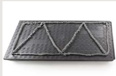
1 Aanbrengen lijm op isolatiepaneel
